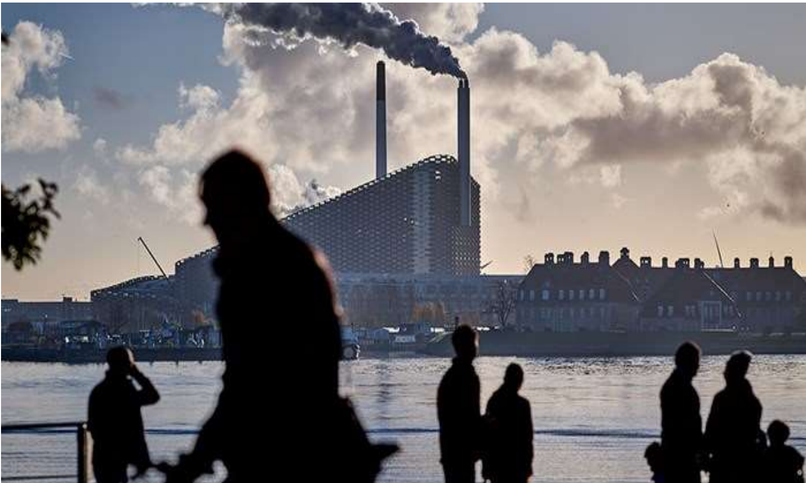
Amager Ressourcecenter, ARC, er en meget markant og ikonisk bygning i det københavnske bybillede (Foto: ARC)
